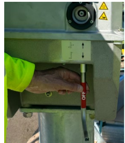
Figur 2: Drivmaskinnøkkel med sperrepinne i låst posisjon
